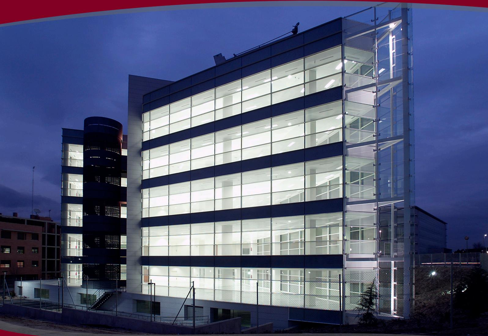
Sistema para fachada ligera tipo "Stick", ensamblados en situ.
